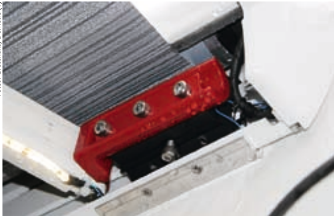
Wichtiges Bauteil: Der Träger aus geschmiedetem Stahl wird mit vier dicken Bolzen an einer Platte auf der Innenseite der Außenwand verankert. So kann er die Kraft der Markise aufnehmen und auf großer Fläche verteilen.
