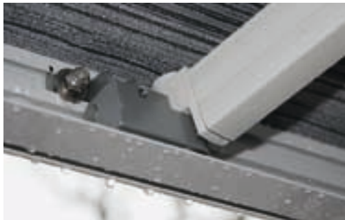
Wichtiges Bauteil: Der Träger aus geschmiedetem Stahl wird mit vier dicken Bolzen an einer Platte auf der Innenseite der Außenwand verankert. So kann er die Kraft der Markise aufnehmen und auf großer Fläche verteilen.
