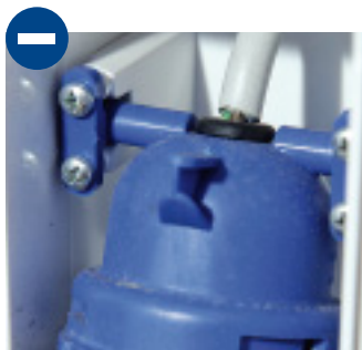
Die Isolierung des E-Anschlusses wurde nicht perfekt durchgeführt.
