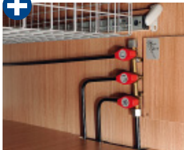
Die Gasabsperrhähne liegen leicht erreichbar im Küchenunterschrank.
