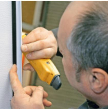
Die Gummileisten unter dem Kantenprofil können im Laufe der Jahre rissig und damit undicht werden.
