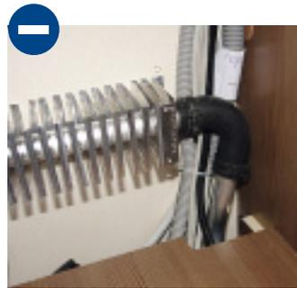
Die Elektroleitungen berühren die Alu-Rohre der Warmwasserheizung.
