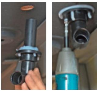
**Step 8:** Bodendurchführung, auch Dichtsockel genannt, von unten her mit reichlich Silikon-Kit einsetzen und mit rostfreien Edelstahlschrauben fixieren.
