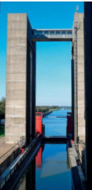
38 Meter Höhenunterschied überbrückt das Schiffshebewerk Scharnebeck.
