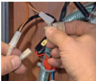
**Step 11:** Das lange Ende des SOG-Kabelsatzes führt der Monteur vom Toilettentafel durch die Bohrung in der Wand zum Gebläsemotor. Diese Kabel sind normal rot und schwarz – bei unserer Montage mussten die Kabel verlängert werden und sind daher braun.
