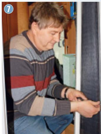
Die Fliegengittertür wird mit dem Rahmen verbunden, der bereits für eine exakte Aufnahme vorbereitet ist.
