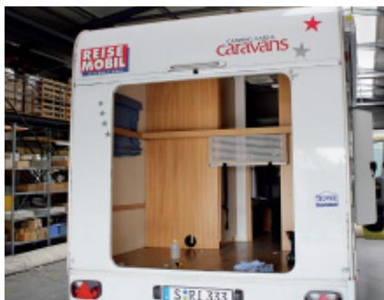
Schnell sind Türen und Rahmen entfernt. Beruhigend: Der Wandaufbau mit Holzfachwerk ist im Bereich des Rahmens trocken und auch sonst intakt.
