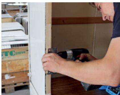
Bevor er den neuen Rahmen einbaut, montiert Tegos-Mitarbeiter Vassily Ussenko die Halbleche für die beiden Gasdruck-Aufsteller.
