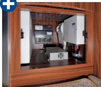
Elektrozentrale sitzt in einem separaten Fach unter dem Kühlzschrank.
