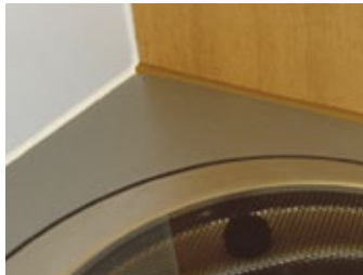
Die zweifarbigen Dichtnähte an der Küche sind fast schon Kunsthandwerk.
