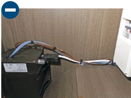
Im Kleiderschrank finden sich lose verlegte Elektroleitungen ohne Kabelkanäle.
