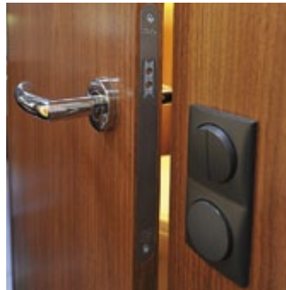
Pfiffig: Die Badtür mit ihrer magnetischen Schließung fungiert optional als Teiler fürs Raumbad.
