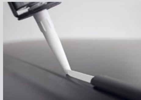
Um eine Dreiecksraupe zu erhalten, schneidet der Monteur entlang einer Prägung der Sika-Düse ein Dreieck aus. Beim Auftragen führt der Monteur die Pistole senkrecht.
