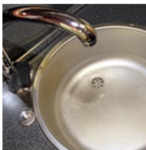
Abgenutzt, schmutzig und verkratzt. Nur gegen die tiefen Kratzer ist die Politur machtlos.
