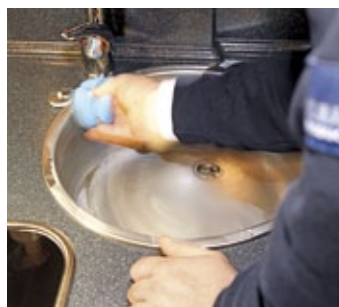
Die meisten Kratzer sind nur oberflächlich. Mit wenig Aufwand sind sie nach ein bis zwei Minuten polieren entfernt.
