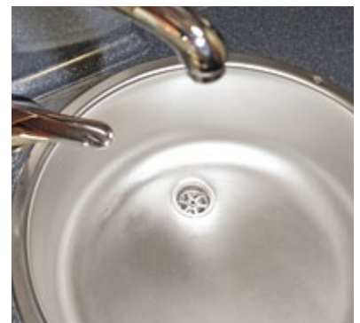
Die meisten Kratzer sind verschwunden, die Oberfläche wieder deutlich geschlossener. So verschmutzt sie sehr viel langsamer.
