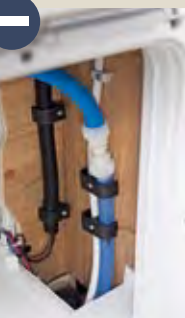
Leider fast branchenweit Standard: Toiletschacht ohne Abdichtung, dafür aber mit offenen Holz-Schnittkanten.
