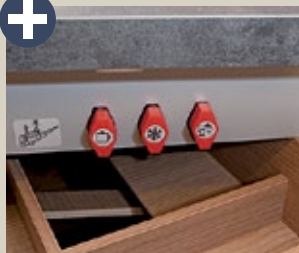
Die Gasabsperrhähne sind in Hüfthöhe montiert.
