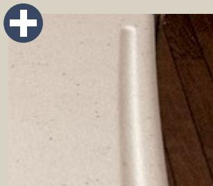
Die Rille verhindert, dass Flüssigkeit von der Arbeitsplatte fließt.
