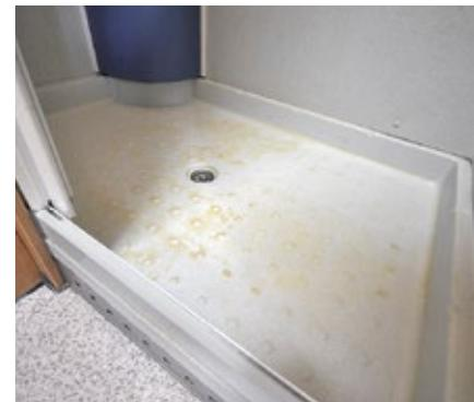
Die Duschtasse zeigt gelbe Flecken – vermutlich von zu scharfem Reiniger. Eine Einlage kaschiert diesen Fehler.
