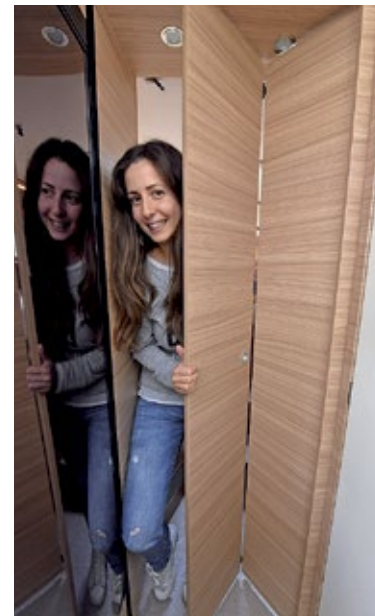
Die Klapptür spart knapp zehn Zentimeter Grundrisslänge.
