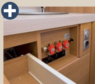
Die Gasabsperrhähne sind im obersten Küchenauszug gut erreichbar.
