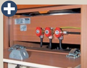
Gut zugängliche Gas-Absperrventile unterhalb der Küchenspüle.
