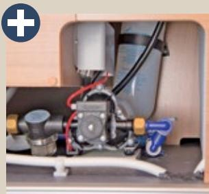
**Dank des Druckspeicherbehälters springt die Druckwasserpumpe nicht so oft an.**
