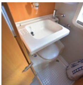
Platzsparend: Das Waschbecken über der Toilette ist klappbar.
