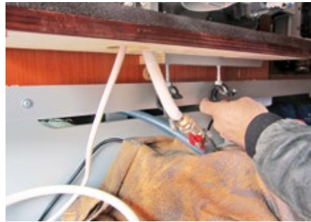
Solide Plattform: Die 17 Kilogramm schwere Waschmaschine will vernünftig und sicher fixiert werden. Stabile Schrauben sind ein Muss.
