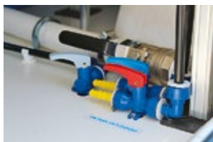
Zugänglich: Ablasshähne und Wassertank im Doppelboden. Die Kanten der Deckel sind unversiegelt.
