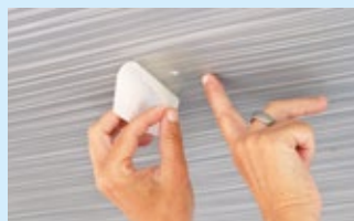
STEP 2: Klebestreifen, falls nötig, zuschneiden. Für unser kleines Loch reicht locker ein halber Streifen. Bei größeren Rissen besser großflächig ausbessern.
