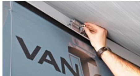
STEP 2: Inbusschrauben mit zwei Unterlegscheiben komplett eindrehen (je weniger U-Scheiben, desto flacher öffnet die Markise).
