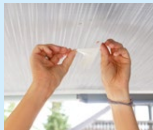
STEP 3: Tuch mit Entfetter oder Silikonentferner entfetten, säubern und trocknen lassen. Jetzt die Klebefolie an einer Kante ansetzen.
