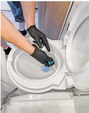
4. Silikonnaht in den Übergang zwischen Schüssel und Twusch geben.
