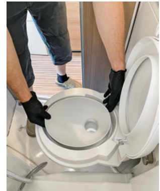
3. Twusch-Keramikeinsatz in die Schüssel setzen und einpassen.
