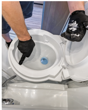
5. Silikonnaht glatt streichen und trocknen lassen.
