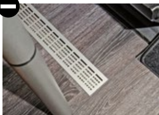
Bodengitter des Konvektors der Alde-Heizung verschmutzt unterm Tisch.
