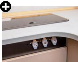
Die Gasabsperrhähne sind sehr gut platziert und ansprechend installiert.
